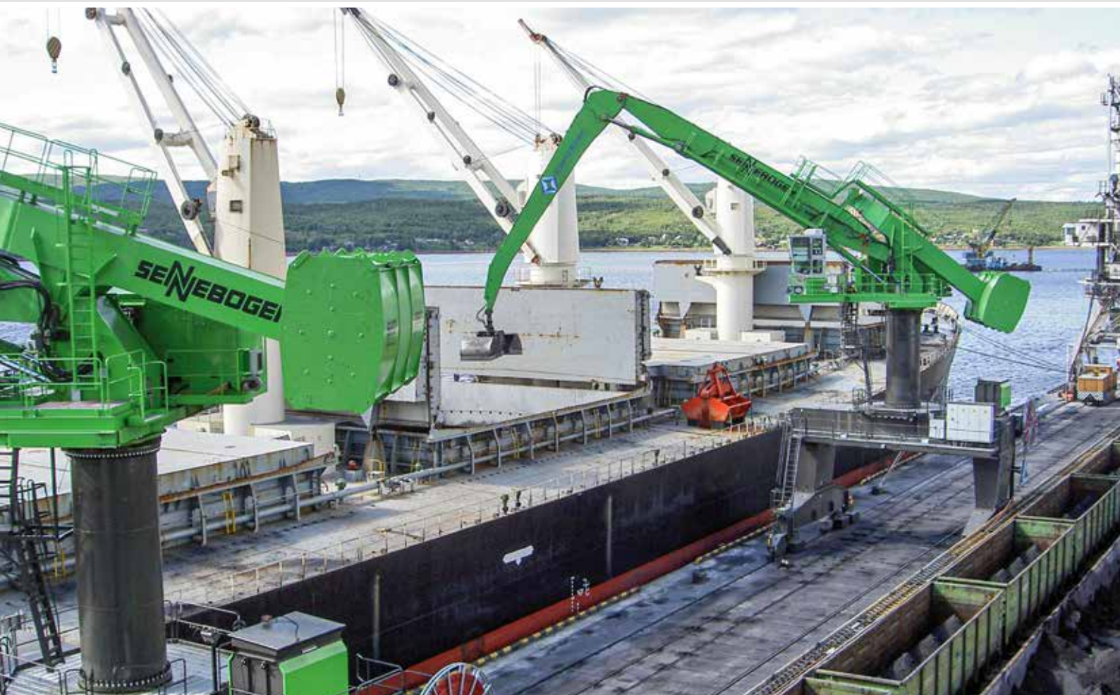
880 EQ Schienenportal Elektro mit spiralig wickelnder Motorleitungstrommel und Leitungsführung; Russland 880 EQ rail gantry electro with monospiral motor cable reel and cable guide; Russia
